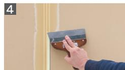
4 バテ処理をします。アタッチメント基部の厚みは0.6mmです。アタッチメントにはバテの付着を良くする細かい溝が付いています。
