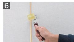
6 アタッチメントにジョイナーをローラーで押さえ込みます。ジョイナーはカッターで切れます。接合部分には接着剤の併用をおすすめします。
