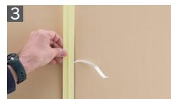
3 両面テープを剥がした後、下地に合った接着剤を塗布し、墨ラインに沿ってアタッチメントを取り付けます。
